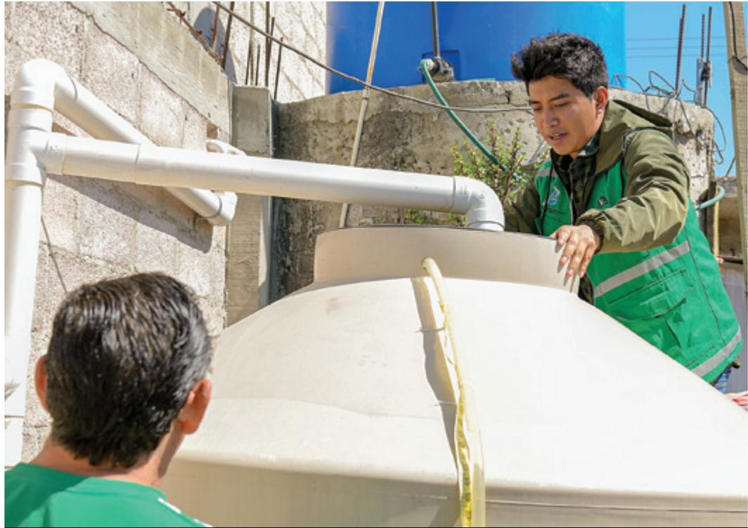
Erik López, de la UAM, revisa el sistema de captación instalado en la casa de Francisco. Los ingenieros de la universidad han liderado las labores del diseño, instalación y mantenimiento del modelo de recolección de agua pluvial. ©Hábitat para la Humanidad / Marco Calvo.
